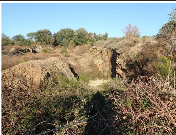
Illustration 9 : Ancienne entrée de galerie comblée, stable
