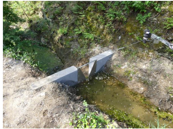
Illustration 42 : Seuil de mesure de débit aménagé au niveau de la station télémétrique
