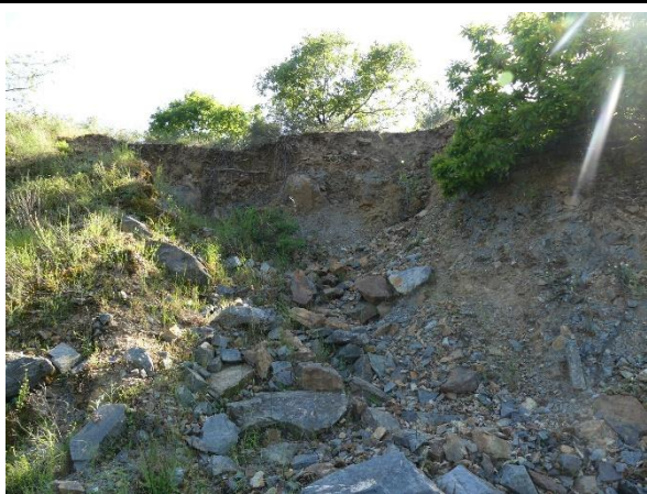
Illustration 31 : Niche d'arrachement prononcée en amont de la partie Sud
