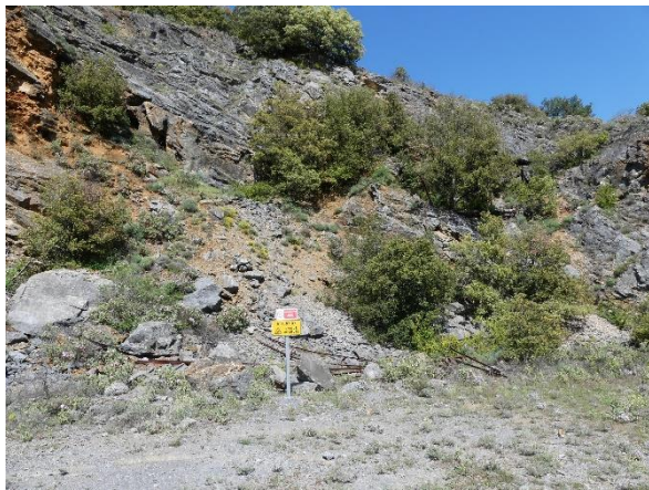
Illustration 21 : Première plateforme de l'ancienne carrière et nouvelle signalétique (panneau jaune)
