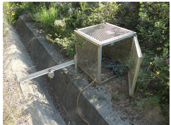
Illustration 52 : Ancien préleveur automatique enlevé au droit du fossé des eaux superficielles
