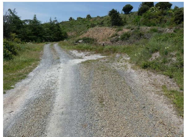
Illustration 46 : Traces de passage d'eau sur le chemin des mineurs
