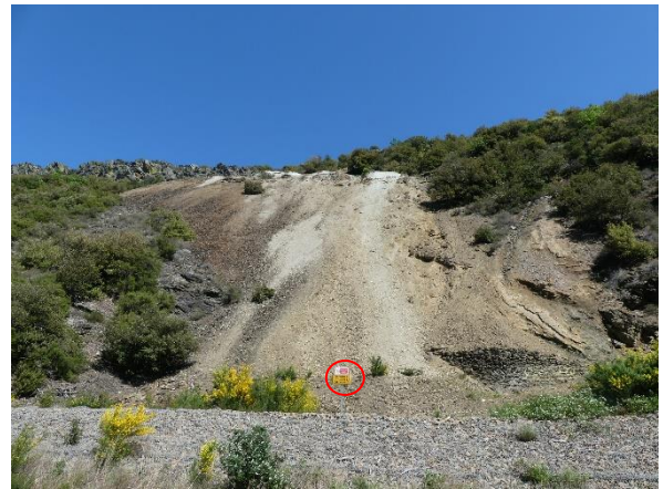
Illustration 14 : Vue en pied de verse, stable et nouvelle signalétique
