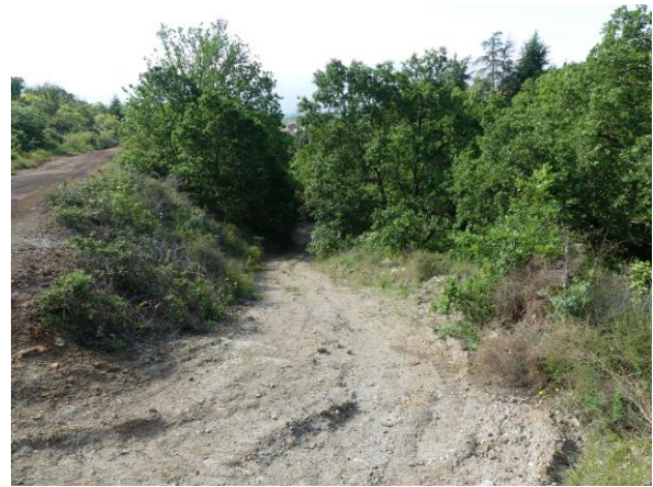
Illustration 36 : Chemin d'accès au bassin tampon
